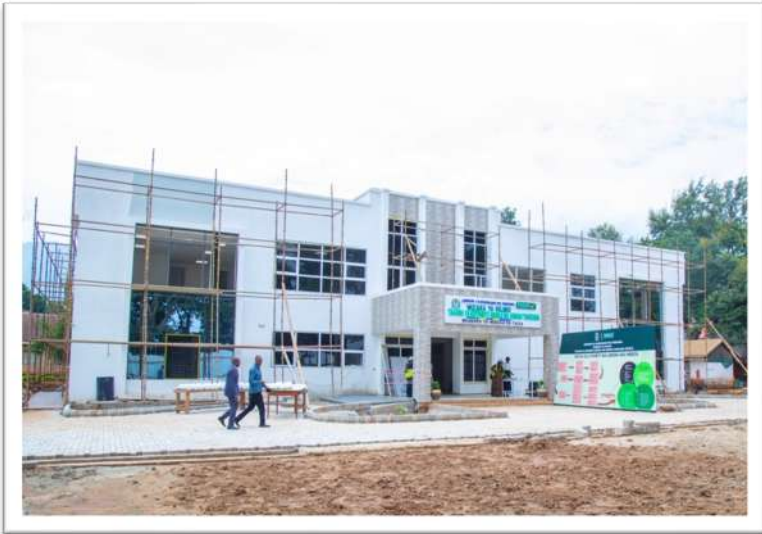
Ujenzi wa Maabara ya Taifa ya Mbegu iliyopo Makao Makuu ya TOSCI - Morogoro
